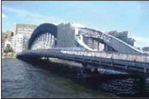
【橋梁の長寿命化対策（永代橋）】
