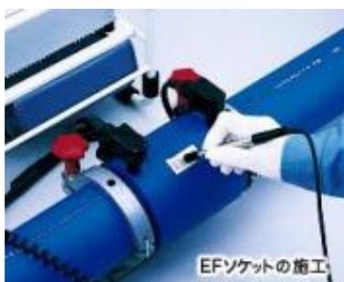
図 1 継手バーコード読み取り
