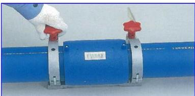
**⚠ 標線を確認し、奥まで挿入されている事を確認。(叩き込み、斜め挿入禁止)**
